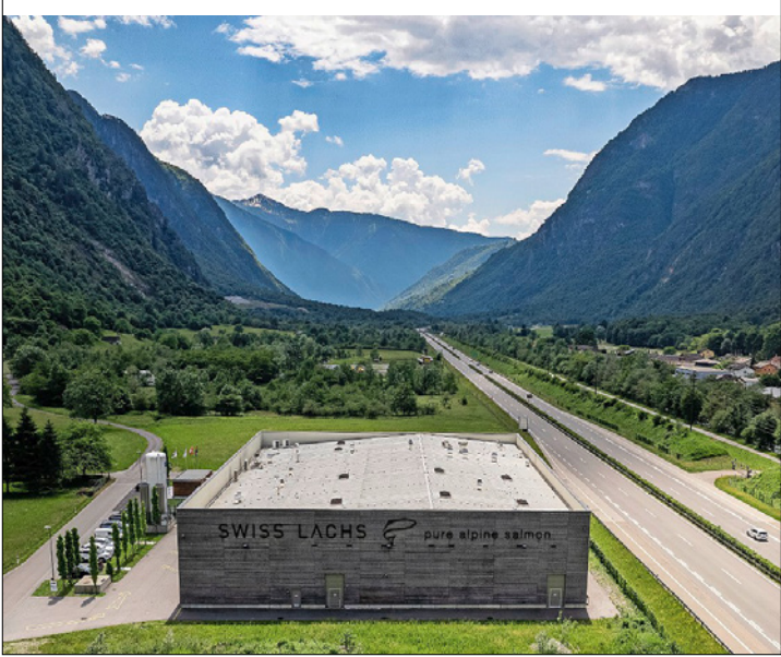
Das Gebäude der Swiss Lachs in Lostallo.
