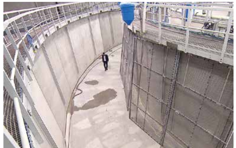
▽ Diese Aufnahme des Salzwassertanks stammt aus der Bauphase der Anlage.
